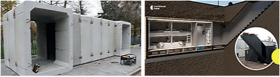
Рис. 1 – Мобільні укриття: а) наземне, б) підземне
